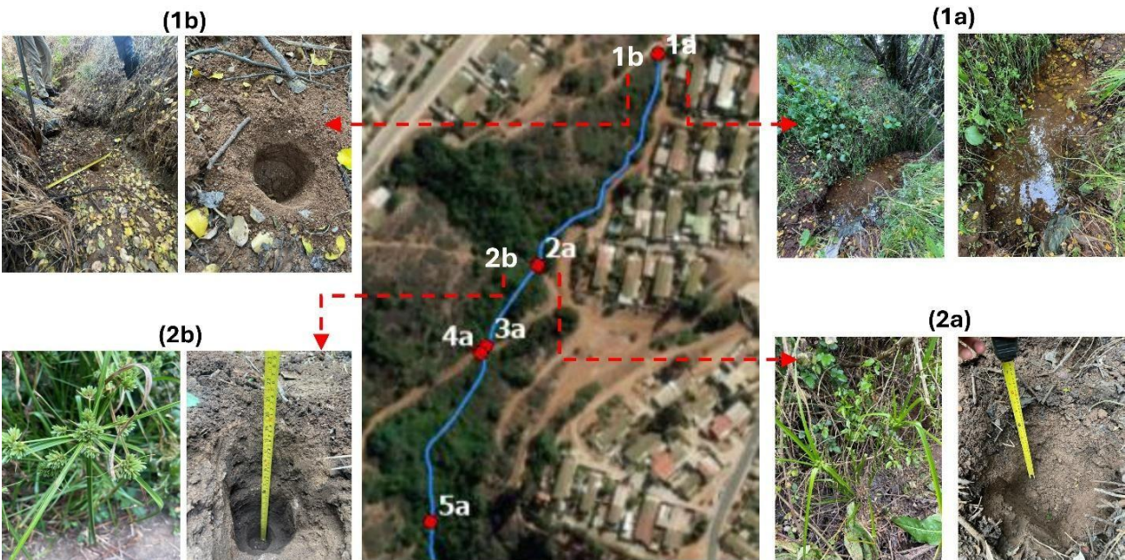
Figura N° 8: Ubicación de los puntos 1a, 1b, 2a y 2b identificados por la SEREMI de Medio Ambiente, situados en el tramo más alto de la Quebrada Principal
