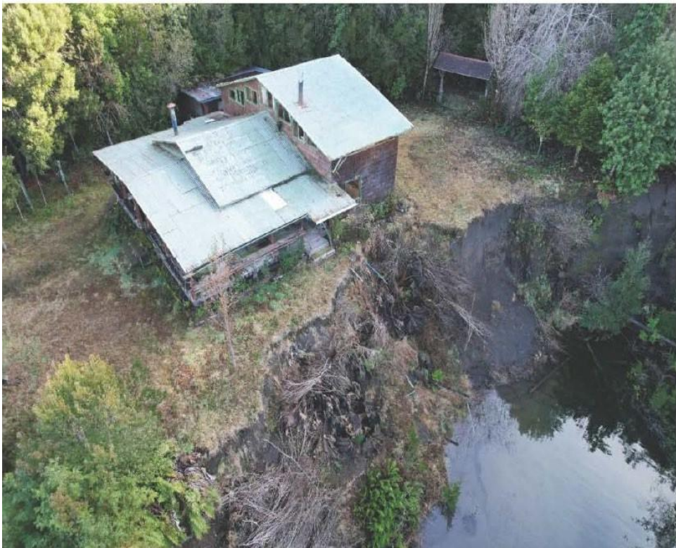
Figura 9. Registro de ribera deteriorada, con desprendimiento de vegetación y vivienda próxima al borde. Fuente: Fotografía presentada a fs. 1264.
